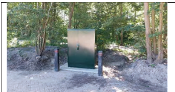
Definitieve centrale elektra-/instrumentenkast
