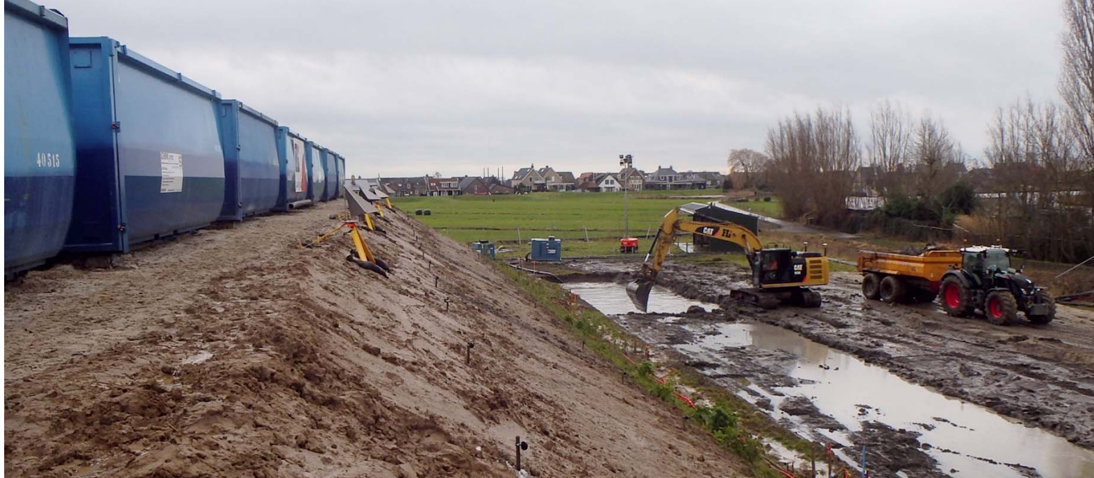
Figuur 7 – Full-scale proef met monitoring instrumentatie in de dijk en op het talud.
